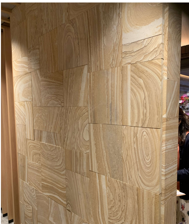
板石の施工例
