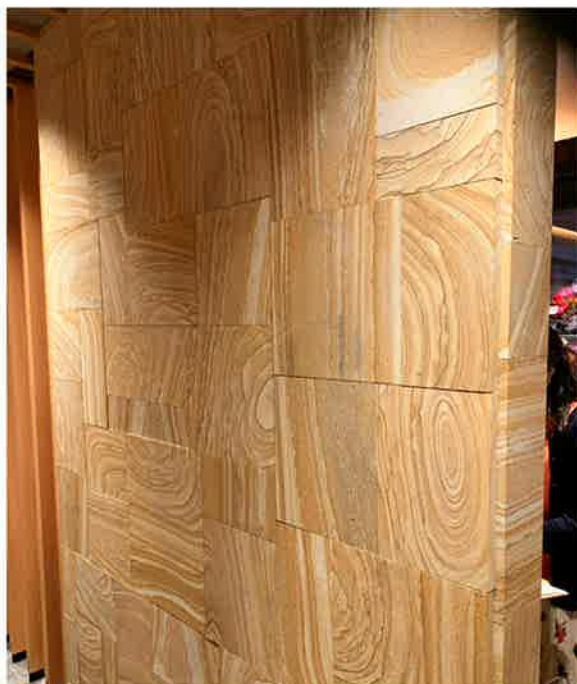
板石の施工例
